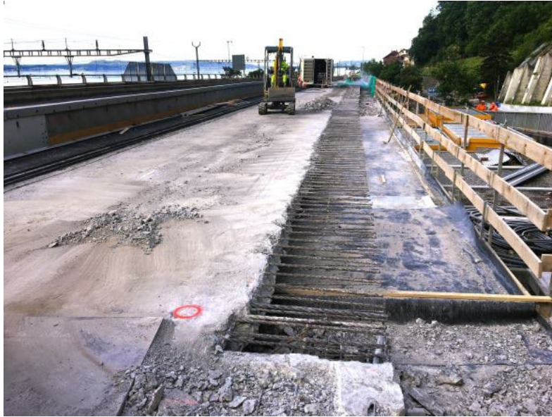
Abb. 3.2 Abbruch des alten Konsolkopfes und frei legen der Anschlussbewehrung auf der Bergseite. Blickrichtung Neuenburg (Stand am 02.06.2021, Foto F. Hunkeler)
