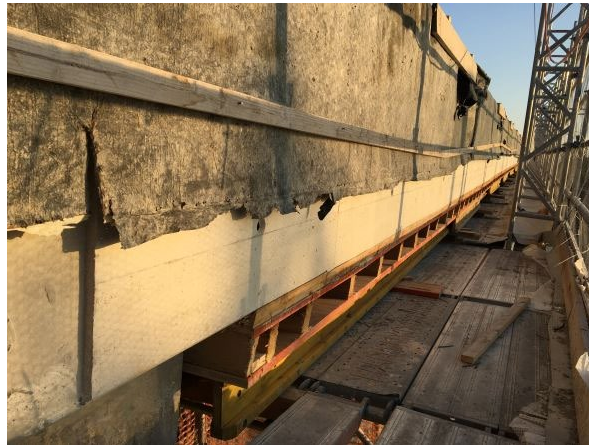
Abb. 5.23 Nachbehandlung der Brüstung auf der Seeseite: a) Innenseite und b) der Aussenseite. Fotos: F. Hunkeler vom 11.10.2021.
