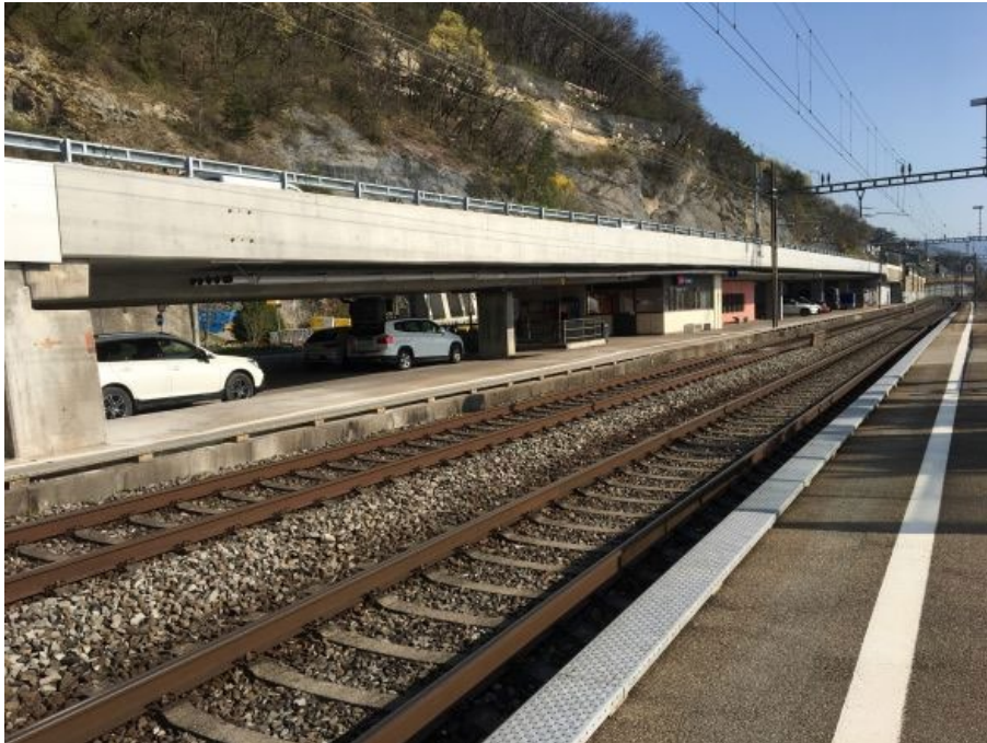
Abb. 6.12 Ansicht der Bahnhofbrücke Tüschierz nach der Instandsetzung. Blickrichtung Biel. Foto F. Hunkeler vom 28.03.2022.
